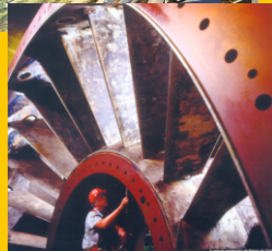
detalle da turbina
